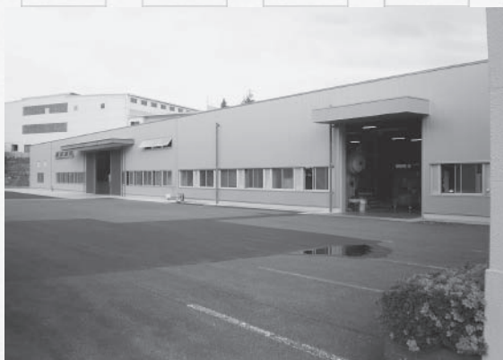
8月に竣工する淡路工場
