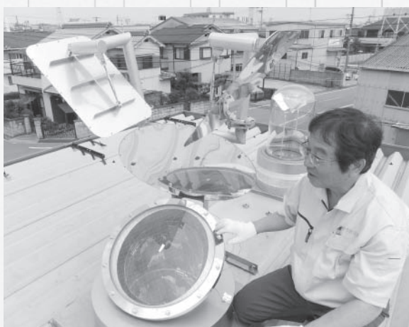
オプションの反射板を取り付けた入光部
