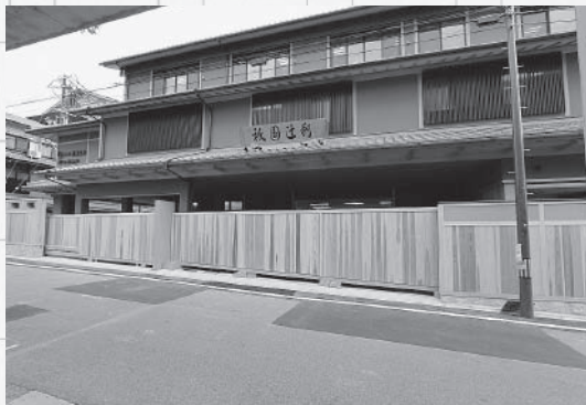
斜面に施工した門扉は自然に開く弱点を克服
