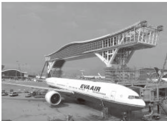
拡張工事が続く香港国際空港
