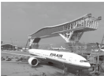
拡張工事が続く香港国際空港
