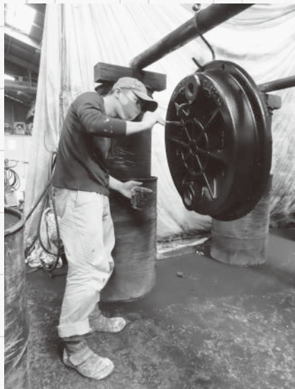
ライニングの仕上げ塗装
