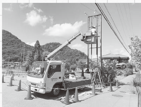
高所作業車を使った看板取り付け工事
