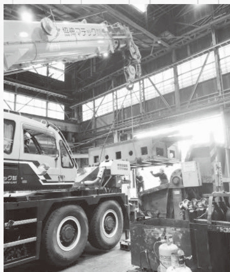
大型重機による解体作業 (左クレーン車、右バックホー)
