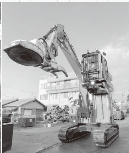
大型重機による解体作業 (左クレーン車、右バックホー)
