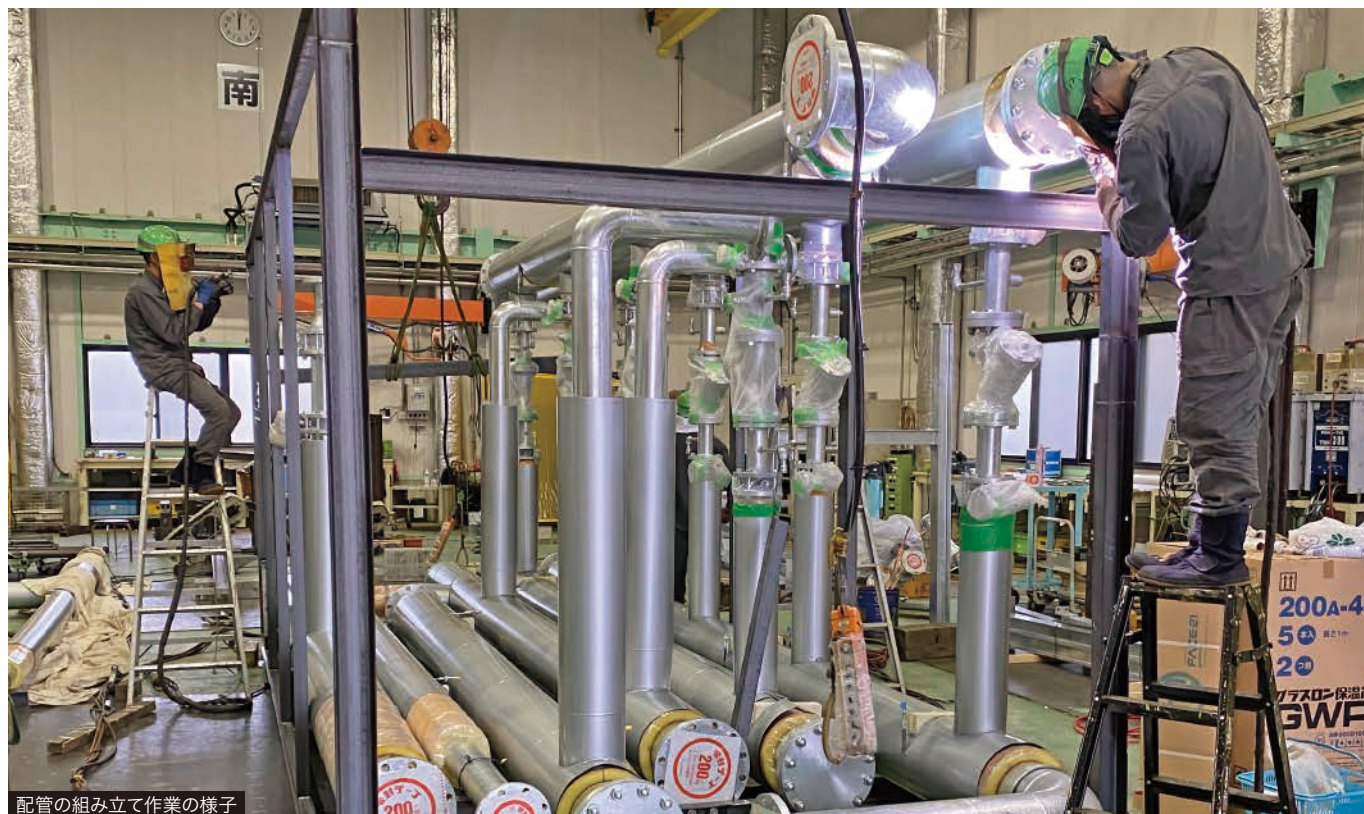
配管の組み立て作業の様子
