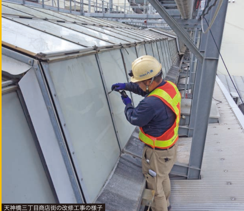
天神橋三丁目商店街の改修工事の様子
