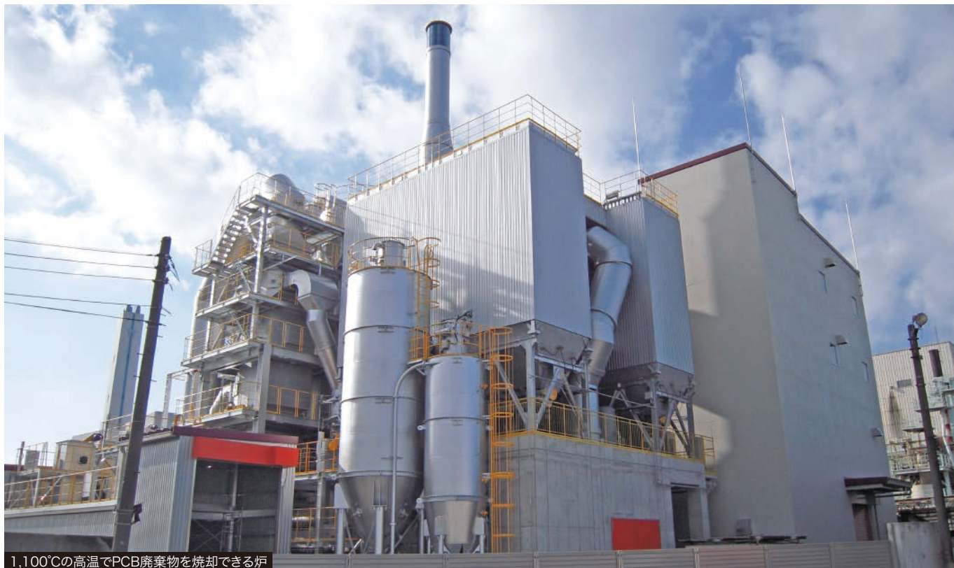
1,100°Cの高温でPCB廃棄物を焼却できる炉
