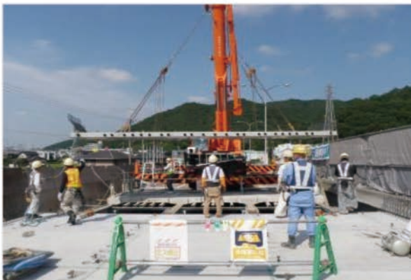
大規模修繕工事が実施中の市川大橋
