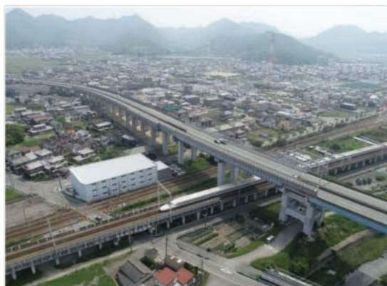
新幹線と JR 山陽本線を跨ぐ新幹線大橋
