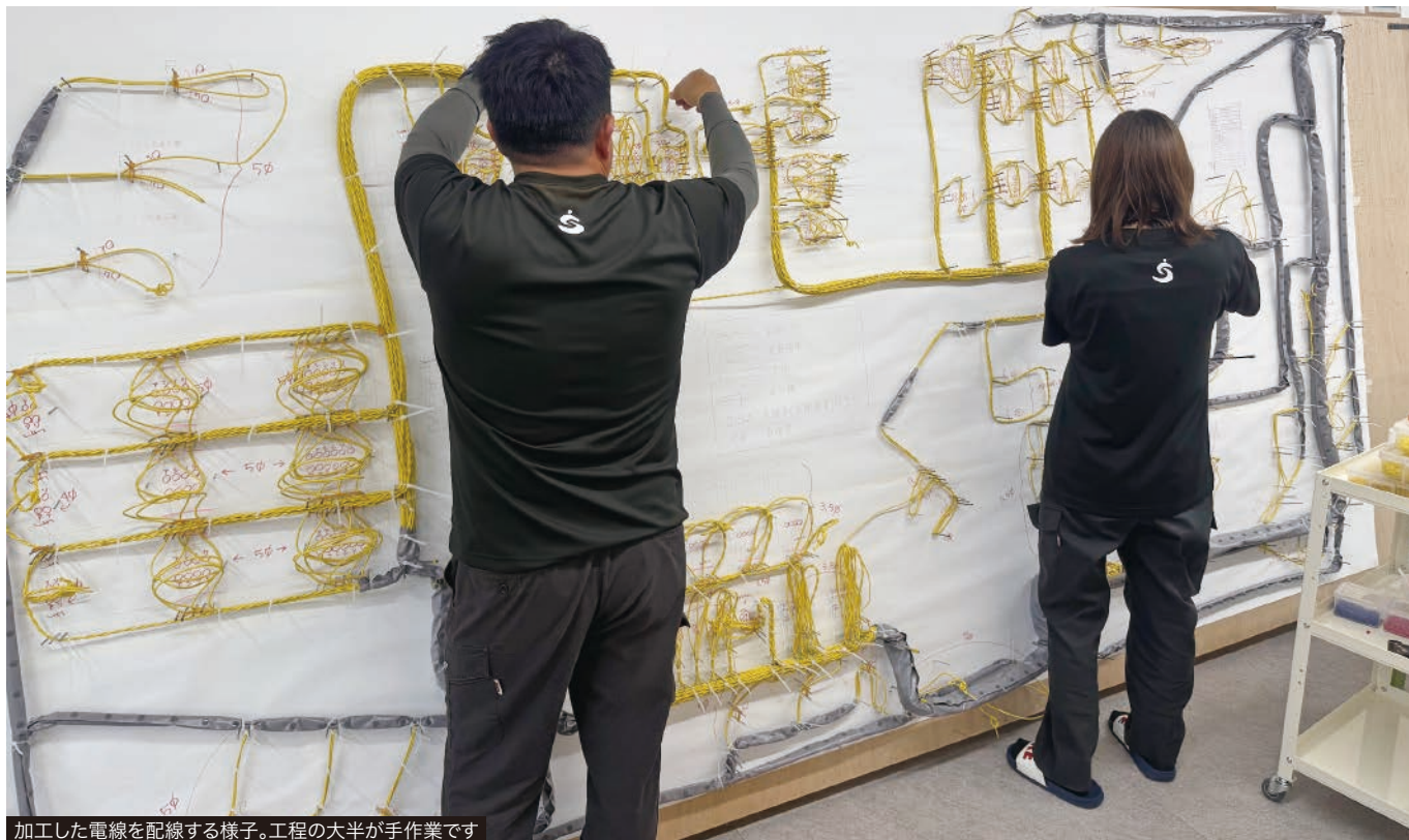
加工した電線を配線する様子。工程の大半が手作業です
