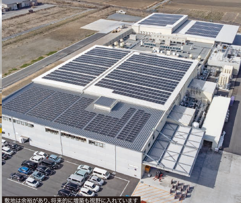
敷地は余裕があり、将来的に増築も視野に入れています
