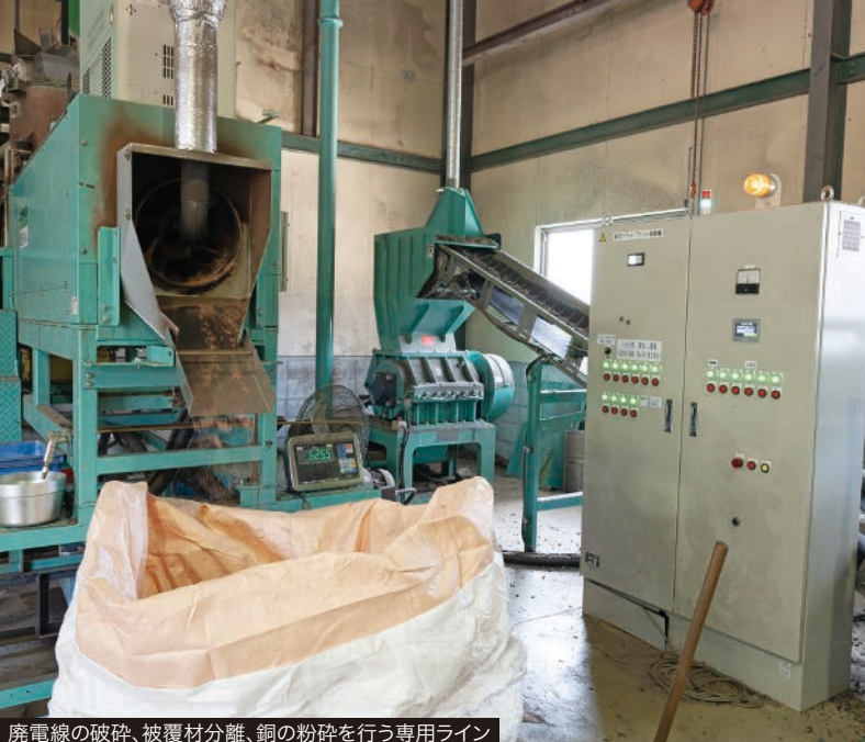
廃電線の破碎、被覆材分離、銅の粉碎を行う専用ライン
