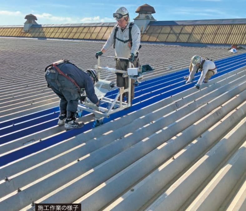
施工作業の様子
