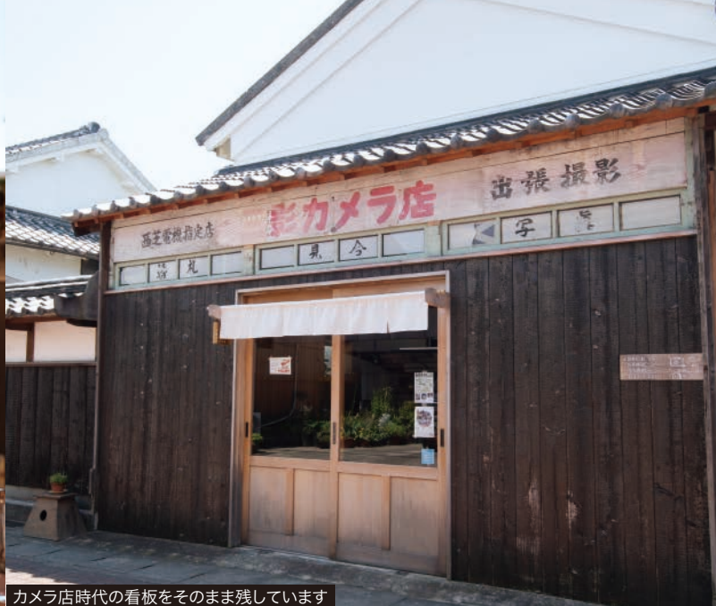
カメラ店時代の看板をそのまま残しています
