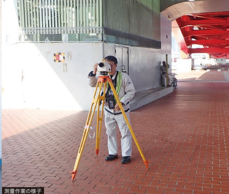
測量作業の様子
