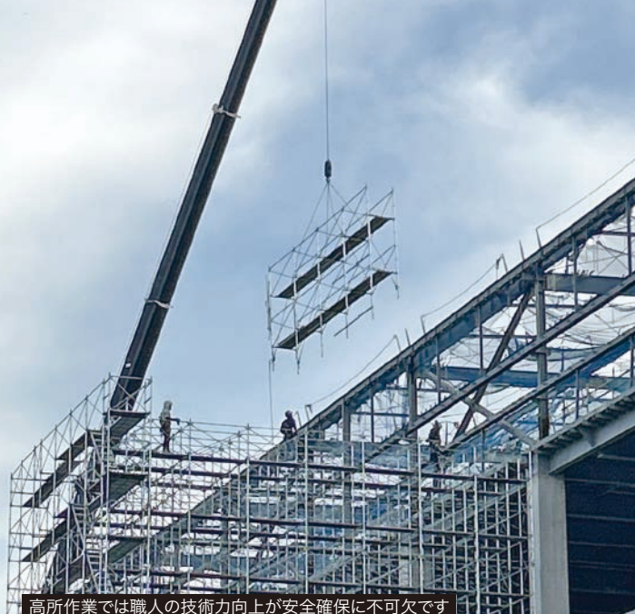
高所作業では職人の技術力向上が安全確保に不可欠です
