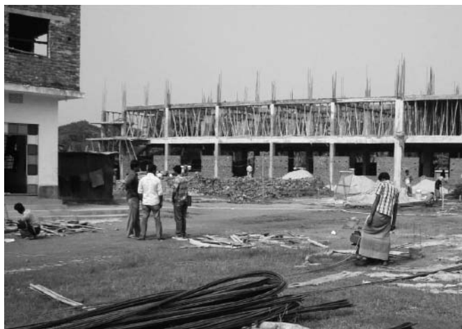
Bangladeshの工場の建設風景
