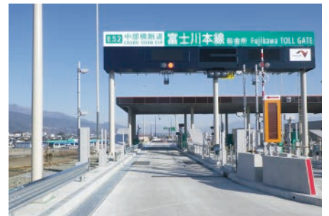
ETCの設置は全国に及びます(写真は山梨県の富士川本線料金所)
