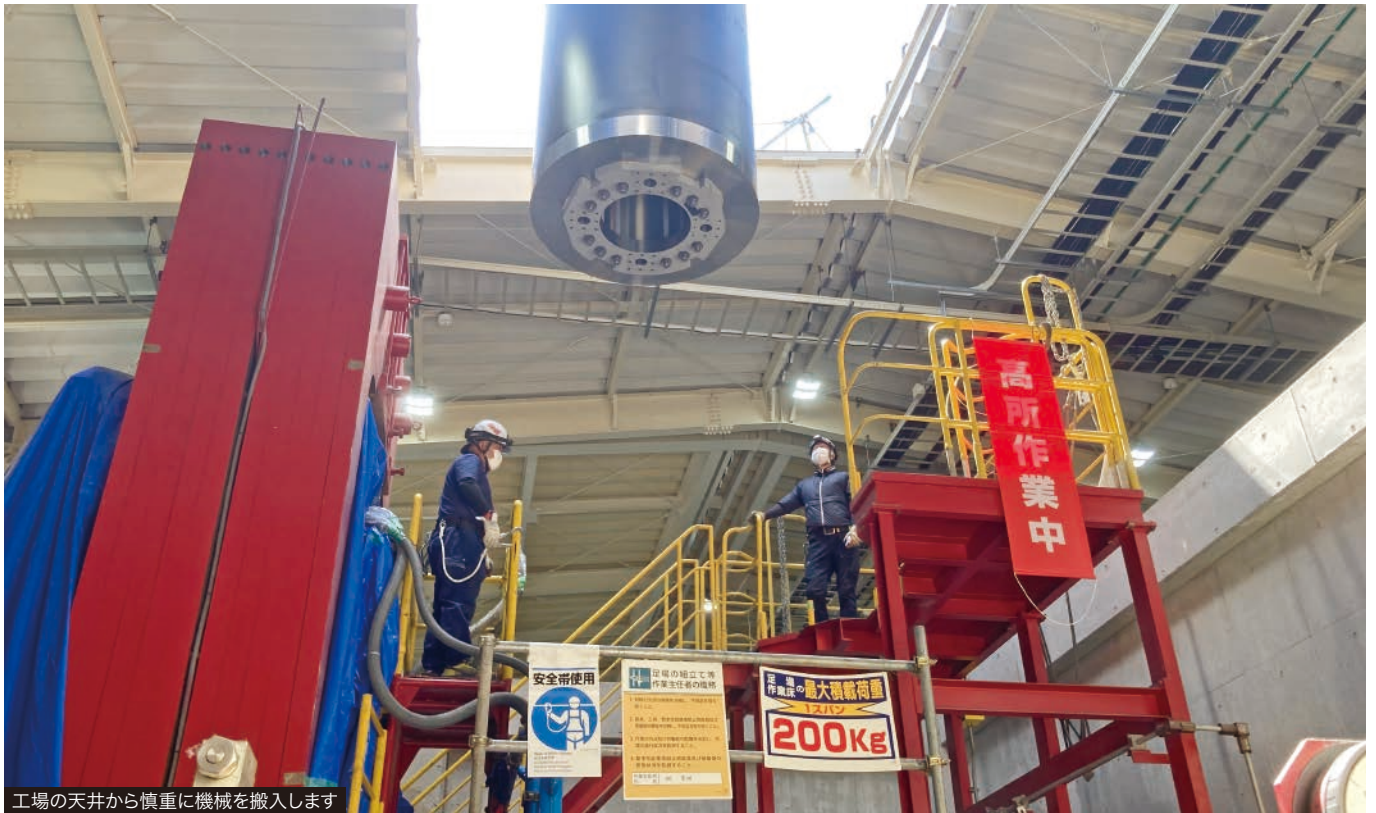
工場の天井から慎重に機械を搬入します
