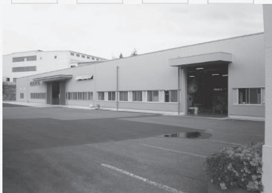
8月に竣工する淡路工場
