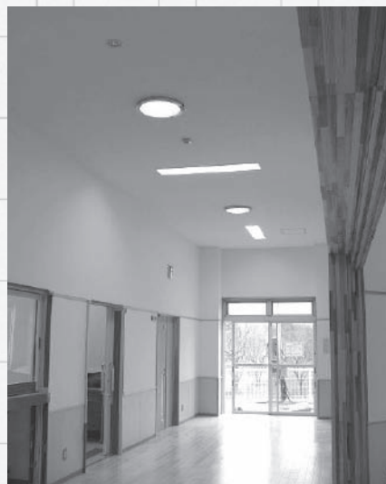
鳥取県の保育園で導入された太陽光採光装置
