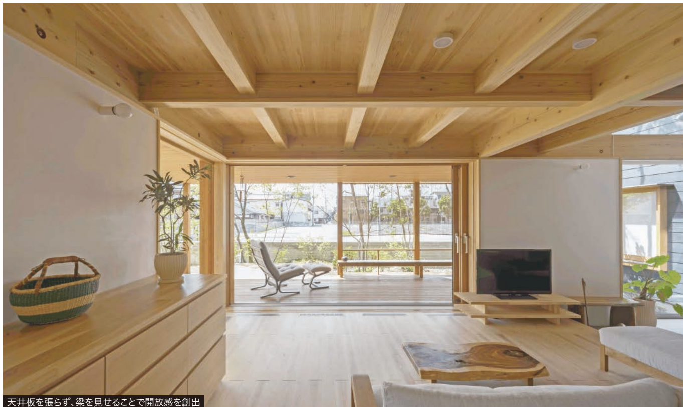
天井板を張らず、梁を見せることで開放感を創出
