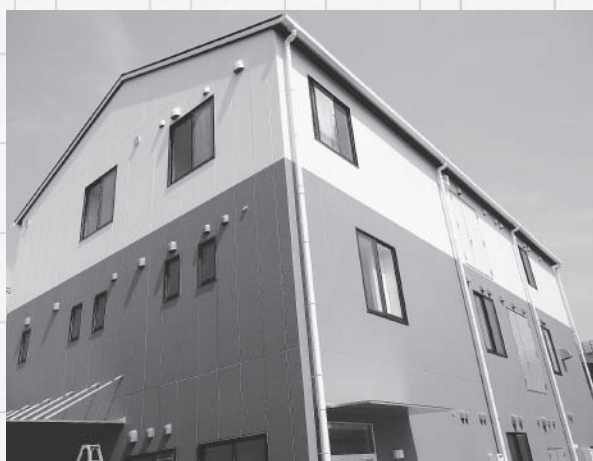
酒蔵の町並みに配慮した外観の新工場
